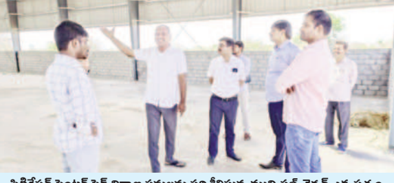
సిగ్రిగేషన్ సెంటర్ షేడ్ నిర్మాణ పనులను పరిశీలిస్తున్న మున్సిపల్ చైర్మన్ ఎడ్ల సత్యం
